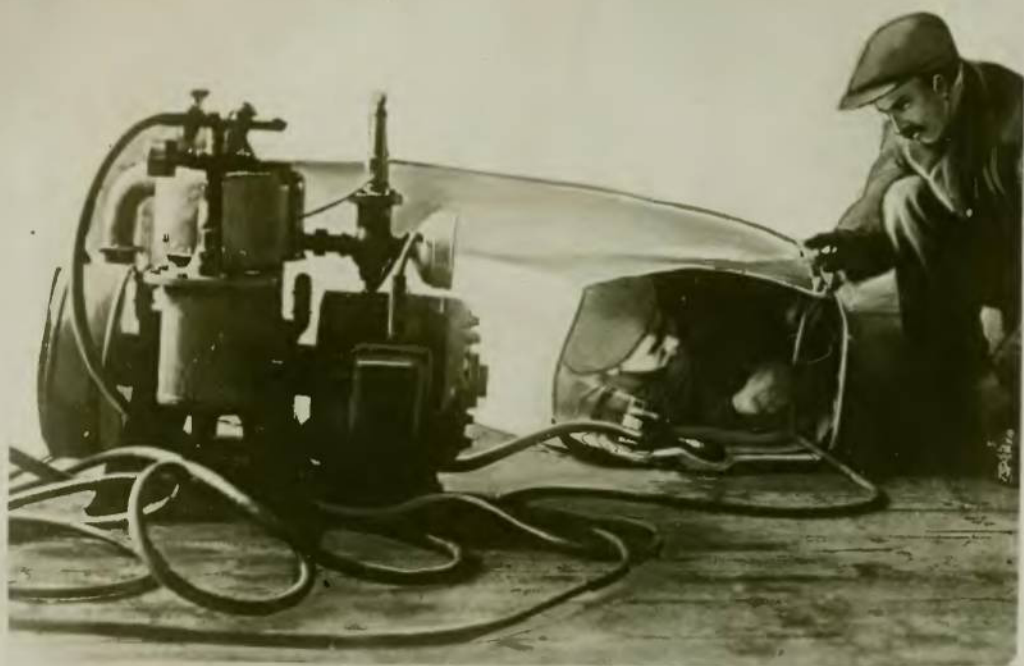
Испытание швов на газонепроницаемость на наполненной 12-метровой модели оболочки дирижабля Циолковского
