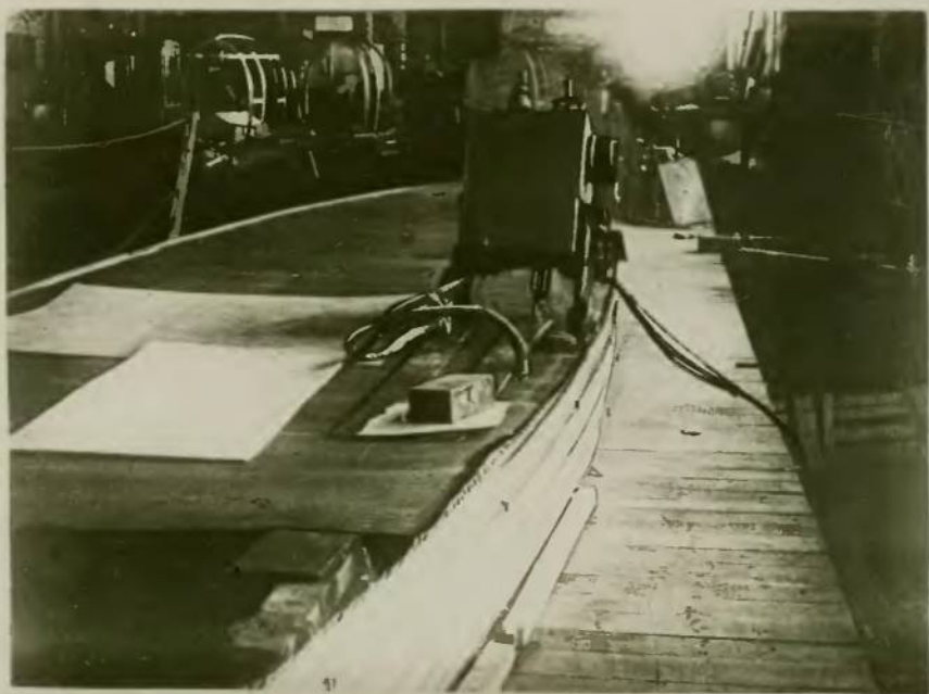
Роликовая электросварочная „двуколка“ Раппопорта и Архипова на сварке модели Цюлковского
