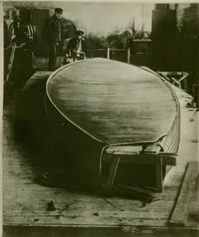
Оболочка 12-метровой модели дирижабля Циолковского в процессе сборки
