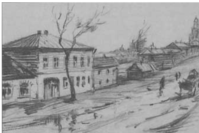
А. И. Котельников. Боровск. Дом, где жили Циолковские. Карандаш, ретушь. 1961–1962 гг. Из собрания ГМИК
